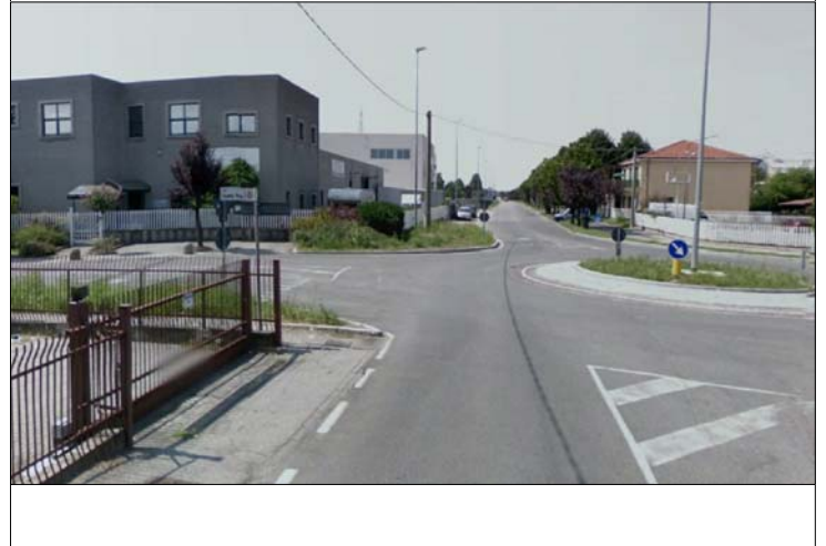
Posizione: Via Monte Rosa - Via Rossa Tipologia: Impianti Nuovi Istituzionali
