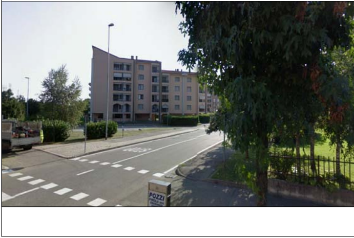
Posizione: Via Volta angolo Via Adda Tipologia: Impianti Nuovi Commerciali
