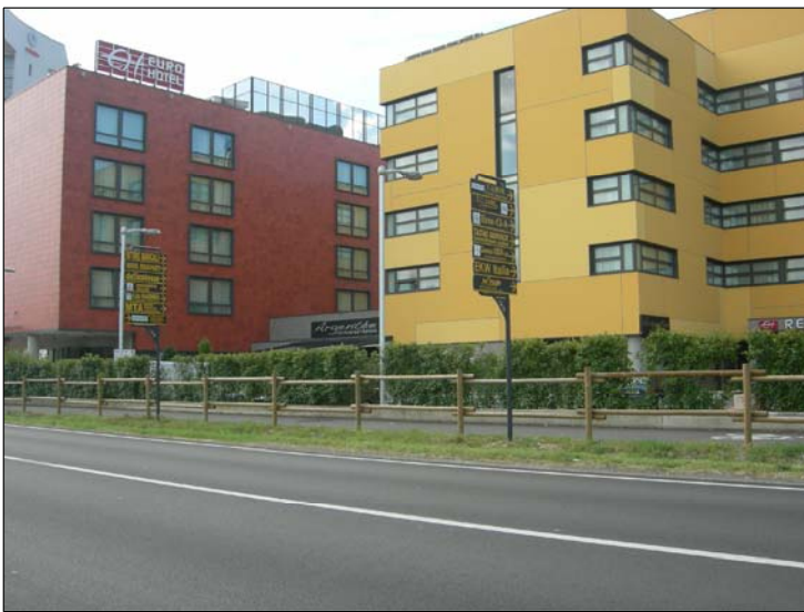
Posizione: SP 2 Tipologia: Impianti Nuovi Commerciali
